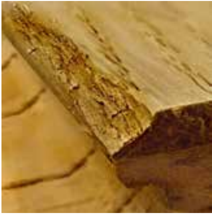
Beschädigte Kanten • damaged edges
